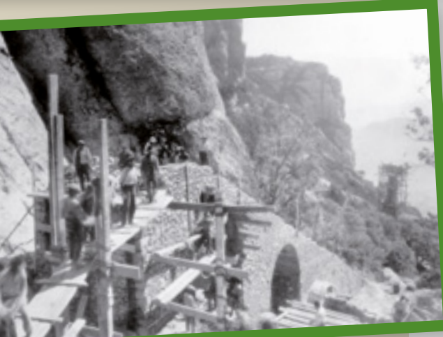
Construcció de la plataforma del funicular. Arxiu FGC (1929).
