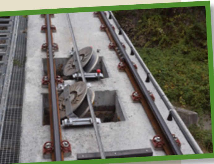
La modernització del funicular ha comportat la substitució de totes les politges per al guiatge del cable. Foto Joan C. Salmerón (2020).
