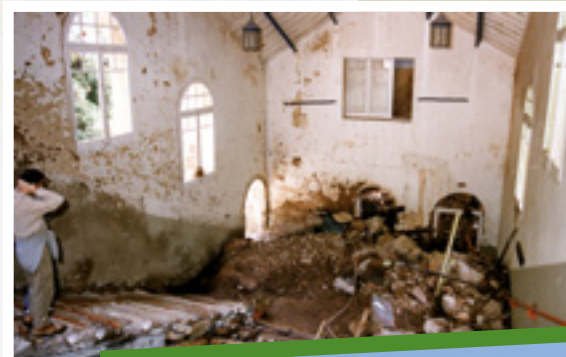
Les inundacions del juny de l'any 2000 van afectar greument les instal·lacions del Funicular de la Santa Cova. Arxiu FGC (2000).
