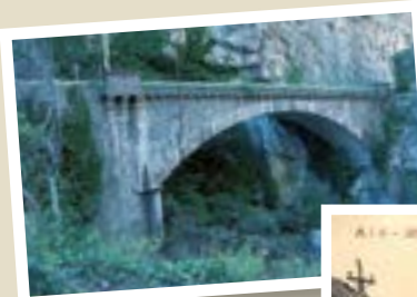
Pont del ferrocarril a Les Coves. Foto: Lluís Garcia Rifà (2010).
