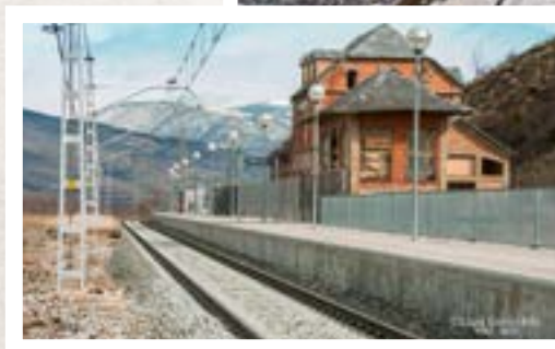
Estació d'Alp sense servei i protegida amb una reixa. Foto: Lluís Garcia Rifà (2012).
