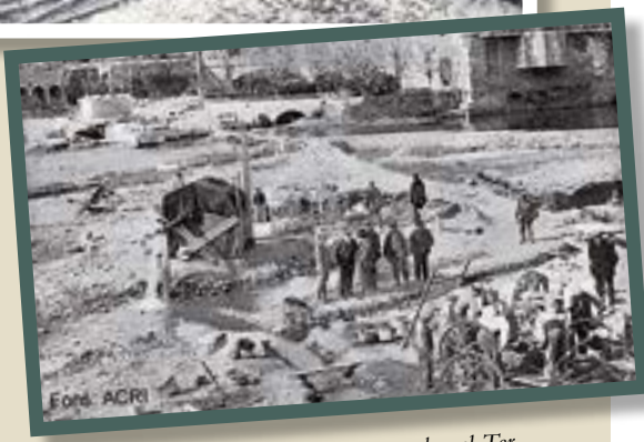
Ripoll - Fonaments del primer pont sobre el Ter. Fons ACRI (vers 1913).
