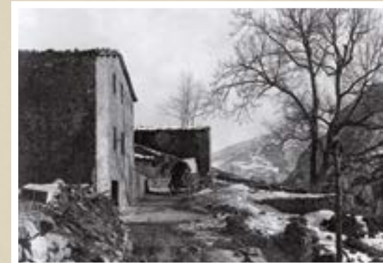
Edificis a Roques Blanques en el Camí de Baix. Autor desconegut (vers 1890).
