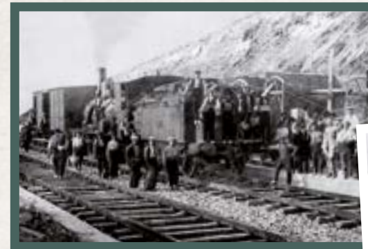
Construcció estació d'Alp. Foto: Wasowsky (Vers 1919).
