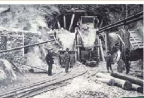
Primers treballs tunel de Toses. Buidat de la volta superior. Autor desconegut (1912).
