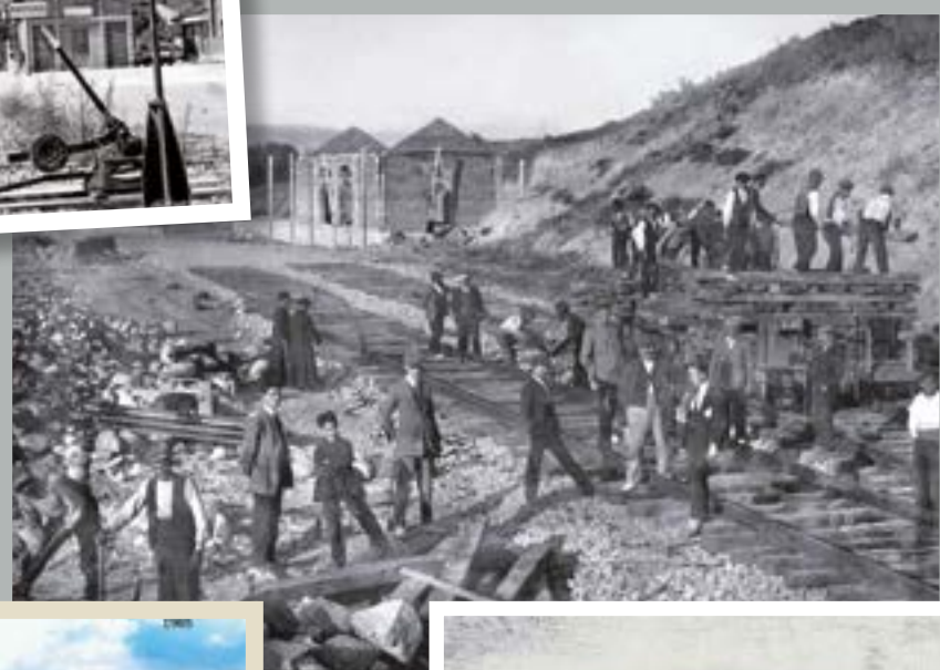
Estació de Queixans (Caixans) en construcció. Sandra Adam Auguer. La Cerdanya desapareguda (1921).
