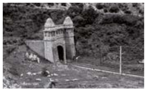
Entrada sud del Túnel de Toses. A sobre, el vell "Camí de Baix" a Cerdanya. Foto: Lluís Garcia Rifà (1983).
