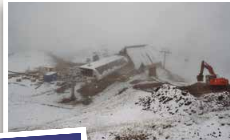
Obres de construcció de l'estació inferior del nou telecabina. Foto Joan C. Salmerón (2019).
