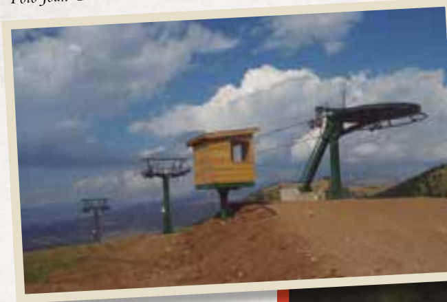
Construcció del nou telecadira El Llac. Foto Joan C. Salmerón (2019).
