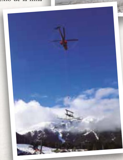
Les pilones del nou telecabina van ser transportades en helicòpter. Foto Daniel Busquets (2018).
