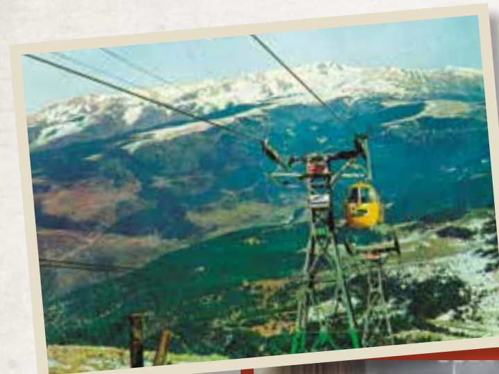
Una de les cabines circulant pel primer tram del telecabina. Arxiu FGC (1965).
