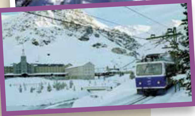
La integració dins d'FGC va comportar l'arribada de nou material mòbil i la modernització de les instal·lacions. Arxiu FGC (2001).
