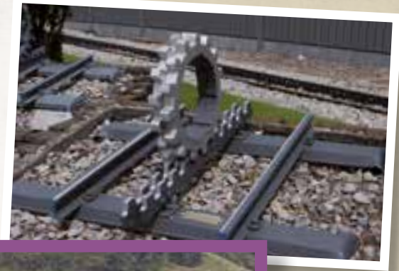
La de Núria és una cremallera del tipus ABT. Foto Joan C. Salmerón (2013).
