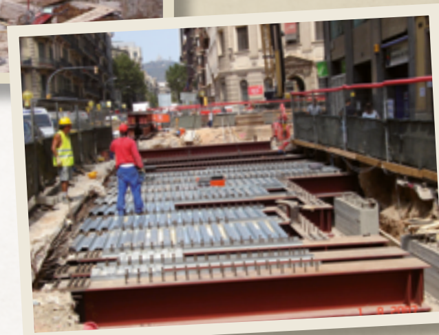
Construcció de la nova llosa sobre el carrer Balmes. Arxiu BAC (2007).
