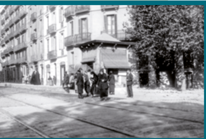
La construcció del baixador subterrani de Provença, alhora que seguien circulant trens per la superfície, va ser especialment complexa. Arxiu FGC (1927).
