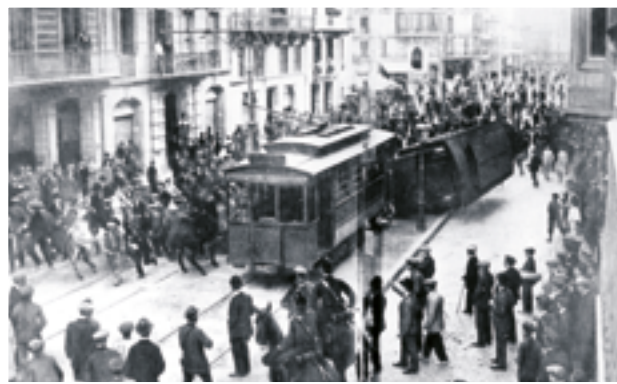
L'arribada dels nous tramvies elèctrics van suposar la retirada de les arcaïques locomotores de vapor que circulaven pel centre de Barcelona. Arxiu FGC (1918).
