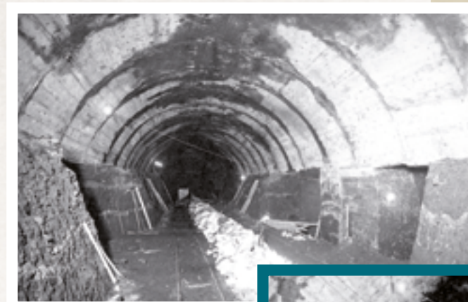
Primeres fases de construcció del túnel sota el carrer Balmes. Arxiu FGC (1927).
