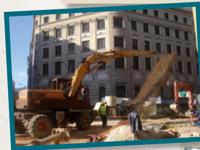
En la construcció del nou intercanviador de Provença va ser necessari la utilització de maquinària pesada. Arxiu BAC (2006).
