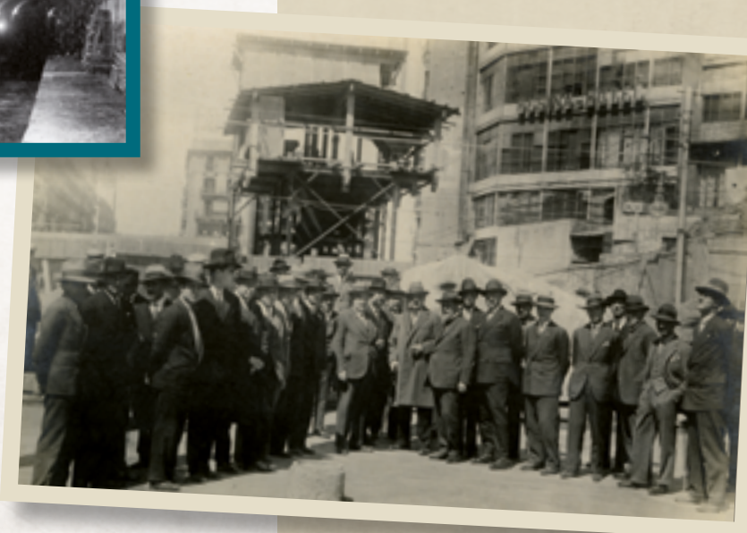
Visita a les obres de soterrament de la línia ferroviària i la construcció del nou baixador. Arxiu COAC (1929).
