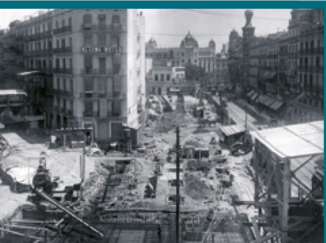
Obres de construcció de la nova estació subterrània de Plaça Catalunya. Arxiu FGC (1926).
