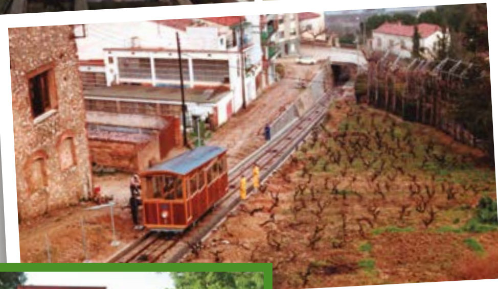
La modernització del funicular també va incloure la renovació de la via i les instal·lacions. Arxiu FGC (1983).
