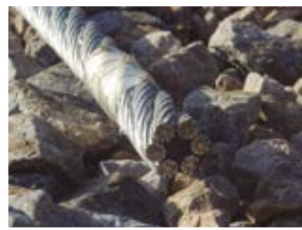
El cable del Funicular de Gelida és una de les peces claus del funcionament d'aquesta instal·lació de transport per cable. Foto Joan C. Salmerón (2019).
