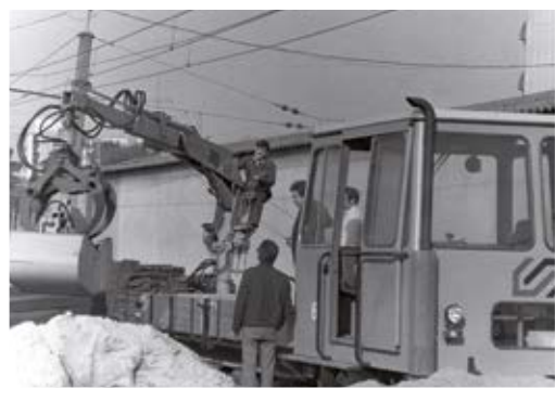
Nou material de manteniment i renovació de vies a l'estació de Rubí. Arxiu FGC (1982).
