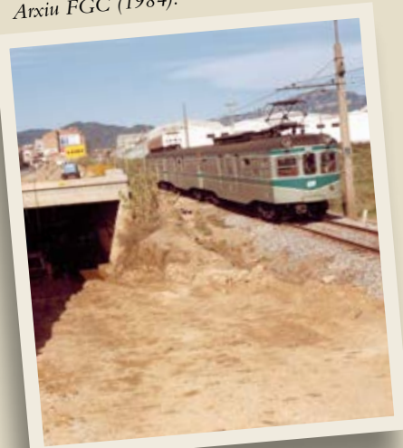
Obres del soterrament de Terrassa. Arxiu FGC (1984).
