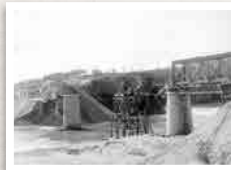
La línia entre Martorell i Monistrol creua el riu Llobregat a Olesa, la qual cosa va comportar la construcció d'un gran viaducte metàl·lic. Arxiu FGC (1921).
