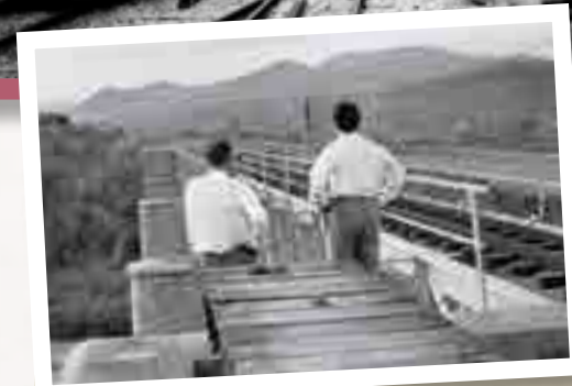
Les obres de renovació, com aquesta al viaducte de Magarola, incloïen la participació d'enginyers i directius de la companyia. Arxiu Salmerón (1965).
