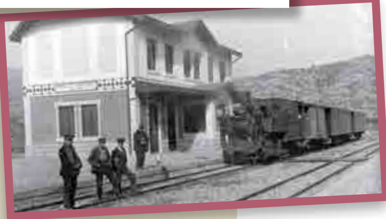
Tren d'obres i de proves de la línia a l'estació de Cremallera de Montserrat Monistrol. Arxiu Salmerón (1922).
