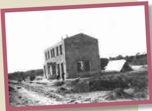
Construcció de l'estació d'Abrera. Arxiu FGC (1921).
