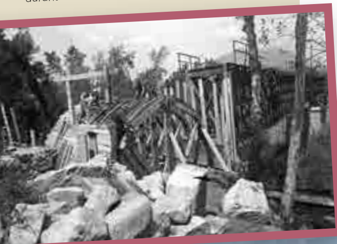
Reconstrucció del viaducte metàl·lic del Llobregat a Olesa de Montserrat, volat durant la Guerra Civil. Arxiu FGC (1940).
