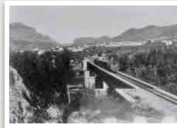
Un llarg tren de passatgers sobre el viaducte del Llobregat a Olesa de Montserrat. Arxiu FGC (c1930).
