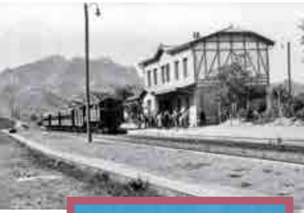
Un tren de passatgers a l'estació d'Olesa durant els primers anys de servei. Arxiu FGC (c1925).
