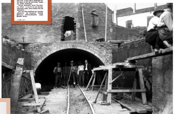
La línia va prolongar-se fins al centre de Sabadell mitjançant la construcció d'un túnel sota el nucli urbà. Arxiu FGC (1924).
