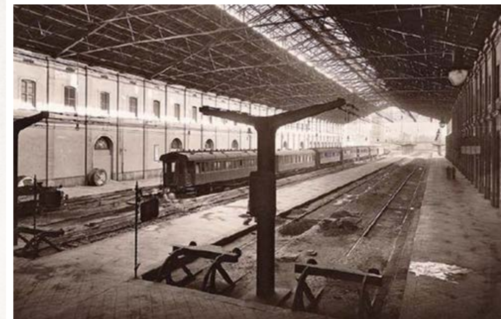
Estació de Barcelona Vilanova. Autor desconegut (anys 30).
