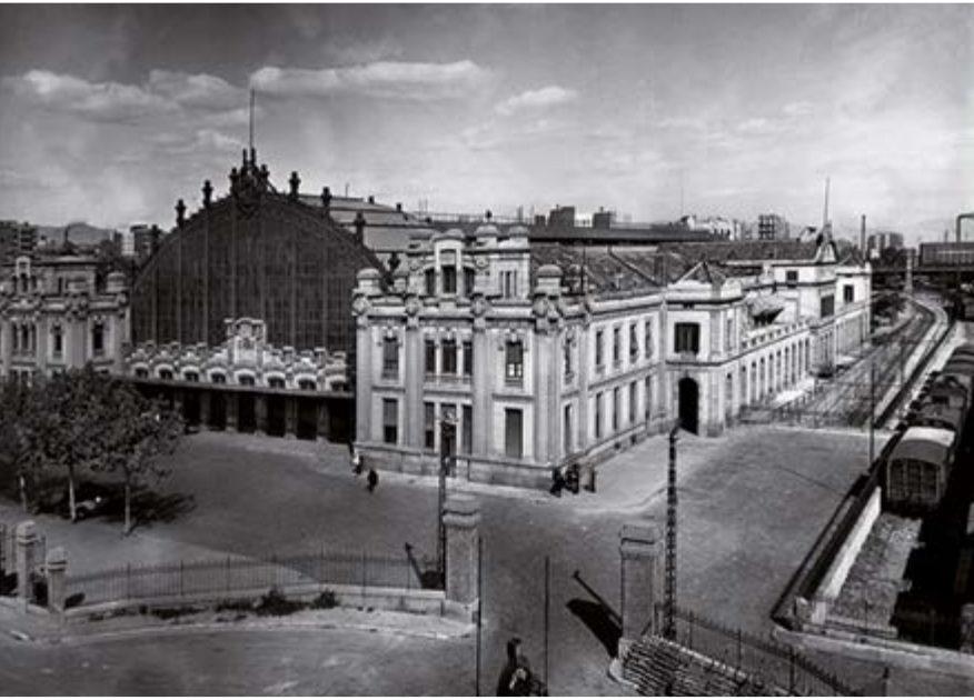
Estació de Barcelona Vilanova. Final de línia dels trens procedents de Lleida, Zaragoza i Sant Joan de les Abadesses. Francesc Ribera. Fons Servei elèctric / MFVG-FFE Ref. 1784 (1944).
