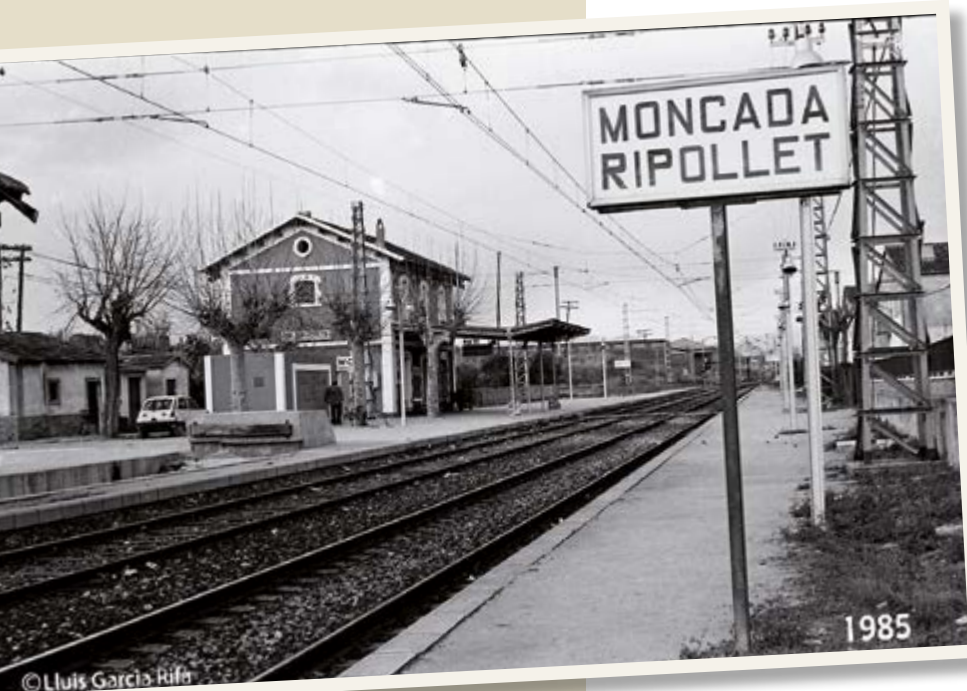
Estació de Montcada Ripollet. Lluís Garcia Rifa (1985).
