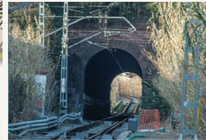
Montcada Reixac. Túnel de la Fermina. Lluís Garcia Rifà (2012).
