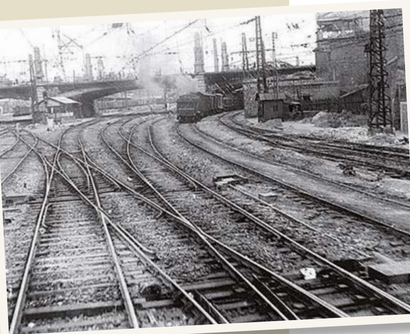
Estació de Barcelona Vilanova. Autor desconegut (anys 50).
