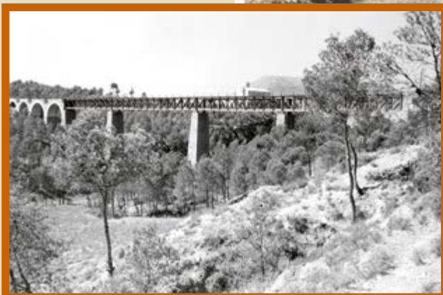
Visió del viaducte de Joncadella, abans de la seva reconstrucció amb arcs de formigó, amb el santuari homònim al fons. Arxiu FGC (1930).
