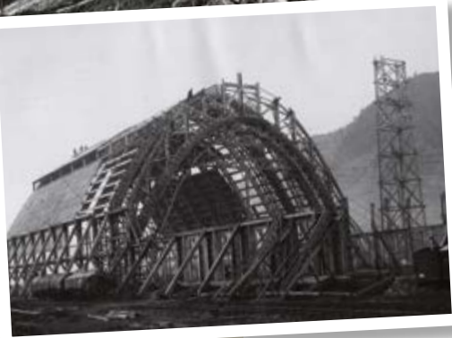
Construcció dels magatzems i les instal·lacions mineres a Sallent. Arxiu ICL Iberia (1934).
