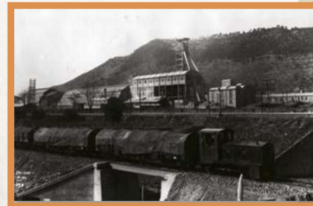
Les diferents instal·lacions mineres han comptat amb locomotores pròpies per a la realització de maniobres. Arxiu ICL Iberia (1934).
