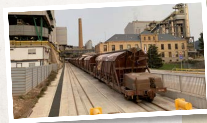
Les maniobres a les instal·lacions de Súrria són realitzades per vehicles bivials. Foto Joan C. Salmerón (2021).
