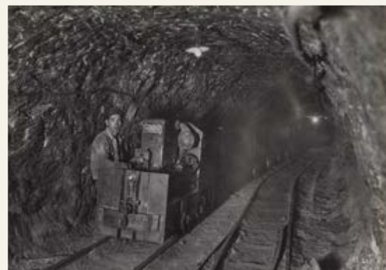
Les galeries mineres del Bages disposaven de petites instal·lacions ferroviàries i maquinària industrial per extreure la producció. Arxiu ICL Iberia (1942).
