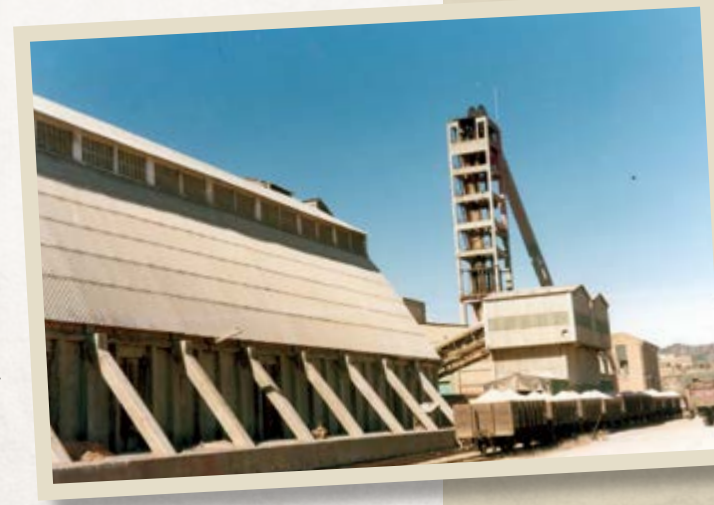
Les instal·lacions mineres de Sallent, amb el seu característic pou de formigó, durant els anys vuitanta. Arxiu FGC (1982).
