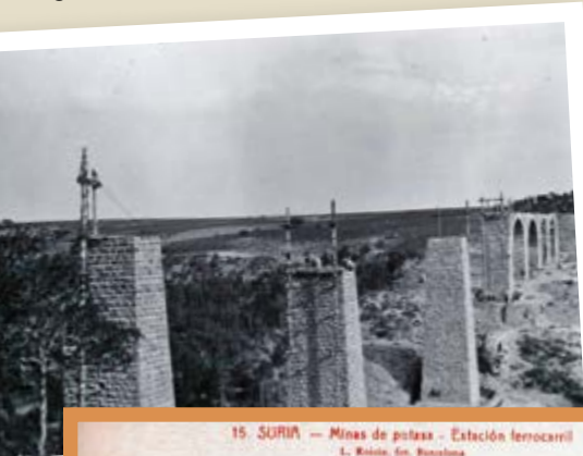
Construcció d'un dels nombrosos ponts i viaductes metàl·lics de la línia de Manresa a Súria. Arxiu ICL Iberia (1919).
