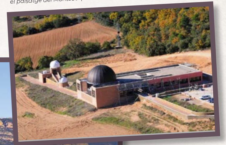
Les cúpules i tota l'arquitectura del COU està perfectament integrada en el paisatge del Montsec. (Jordi Bas).
