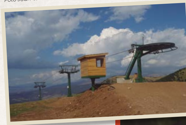
Construcción del nuevo telesilla El Llac. Foto Joan C. Salmerón (2019).
