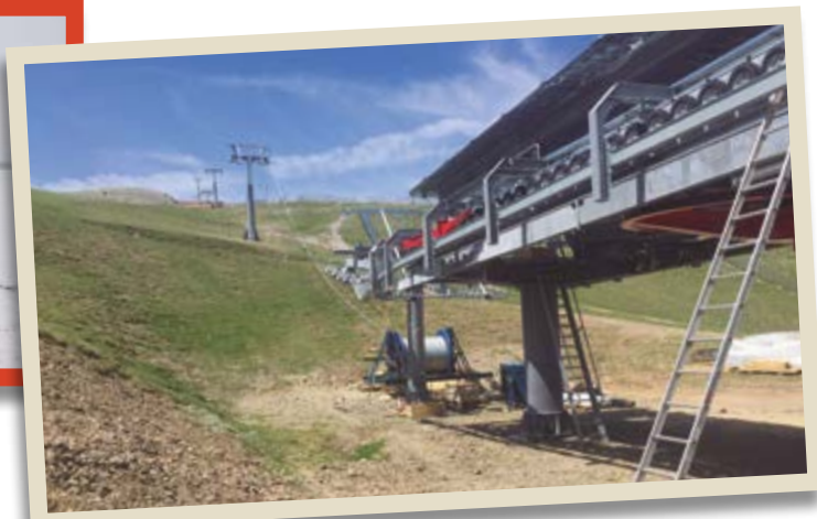
Trabajos de tendido del cable. Foto Daniel Busquets (2019).
