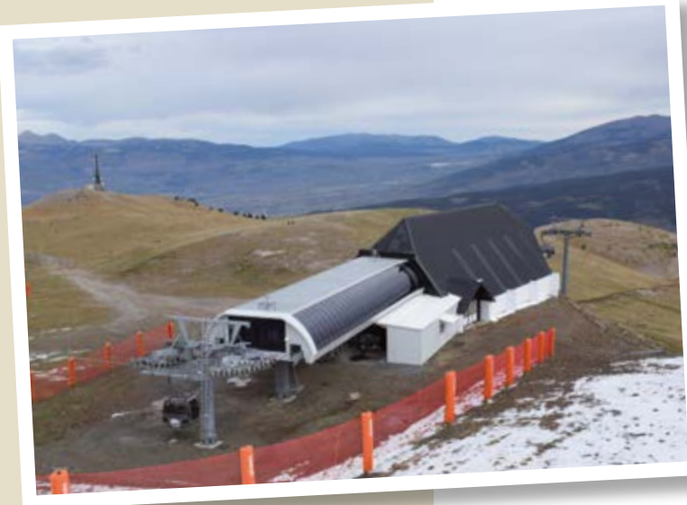
La estación inferior del nuevo telecabina del Cadí - Moixeró. Foto Joan C. Salmerón (2019).
