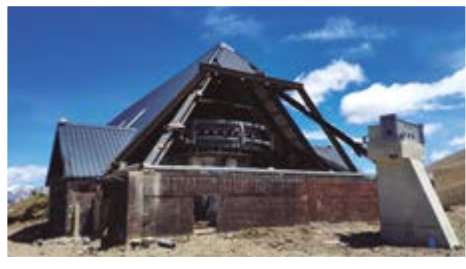
Inicio de las obras en la estación superior del telecabina de La Molina. Foto Daniel Busquets (2019).
