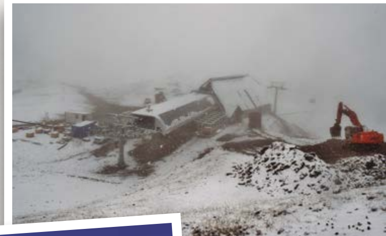
Obras de construcción de la estación inferior del nuevo telecabina. Foto Joan C. Salmerón (2019).
