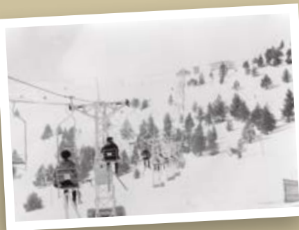
En los años cincuenta la afluencia de nuevos esquiadores impulsó la construcción de nuevas telesillas. Archivo FGC (c1950).
