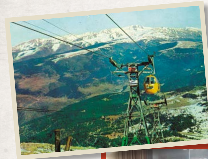
Una de las cabinas circulando por el primer tramo del telecabina. Archivo FCC (1965).
