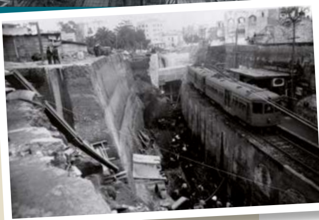
El soterramiento del Tren de Sarrià, sin cortar el servicio de viajeros, comportó la ejecución de complicadas obras de ingeniería. Archivo Salmerón (1927).
