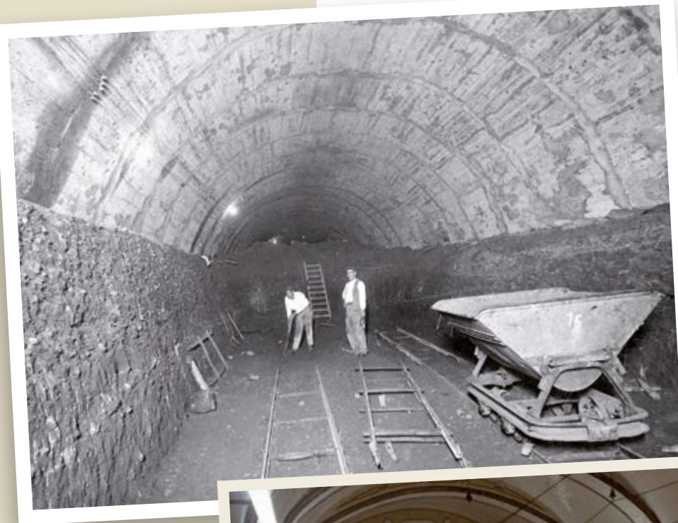
Obras de construcción del soterramiento en la calle Balma. Archivo FGC (1928).
