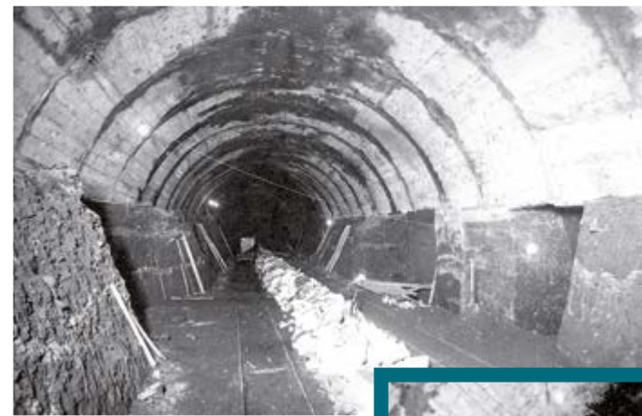
Primeras fases de construcción del túnel bajo la calle Balmes. Archivo FGC (1927).
