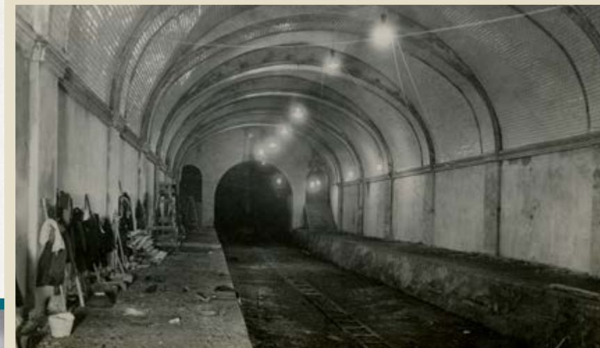
Últimas fases de construcción del nuevo apeadero de Provença. Archivo COAC (1928).
