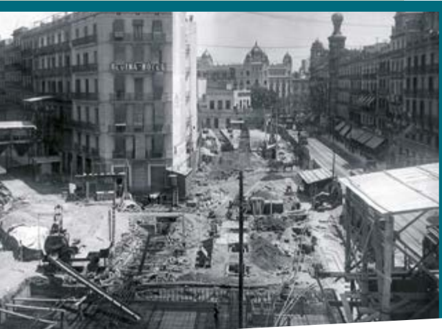
Obras de construcción de la nueva estación subterránea de Plaça Catalunya. Archivo FGC (1926).
