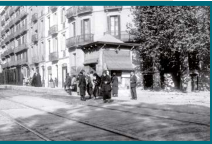
La construcción del apeadero subterráneo de Provença, a la vez que seguían circulando trenes por la superficie, fue especialmente compleja. Archivo FGC (1927).
