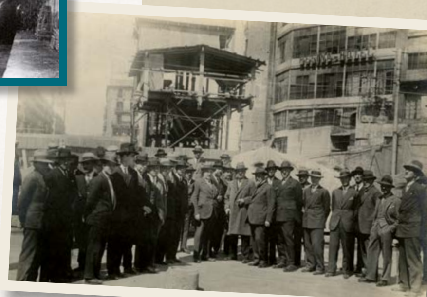
Visita a las obras de soterramiento de la línea ferroviaria y la construcción del nuevo apeadero. Archivo COAC (1929).
