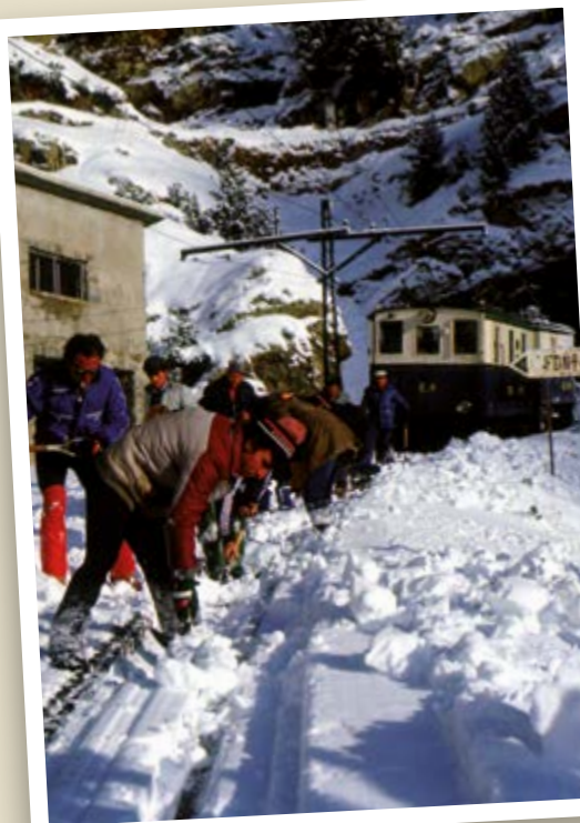
Limpieza de la vía del Cremallera de Núria. Archivo FGC (1983).
