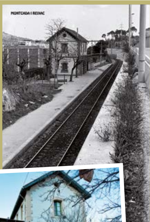
Estación de Montcada Reixac. Lluís García Rifà (1985).
