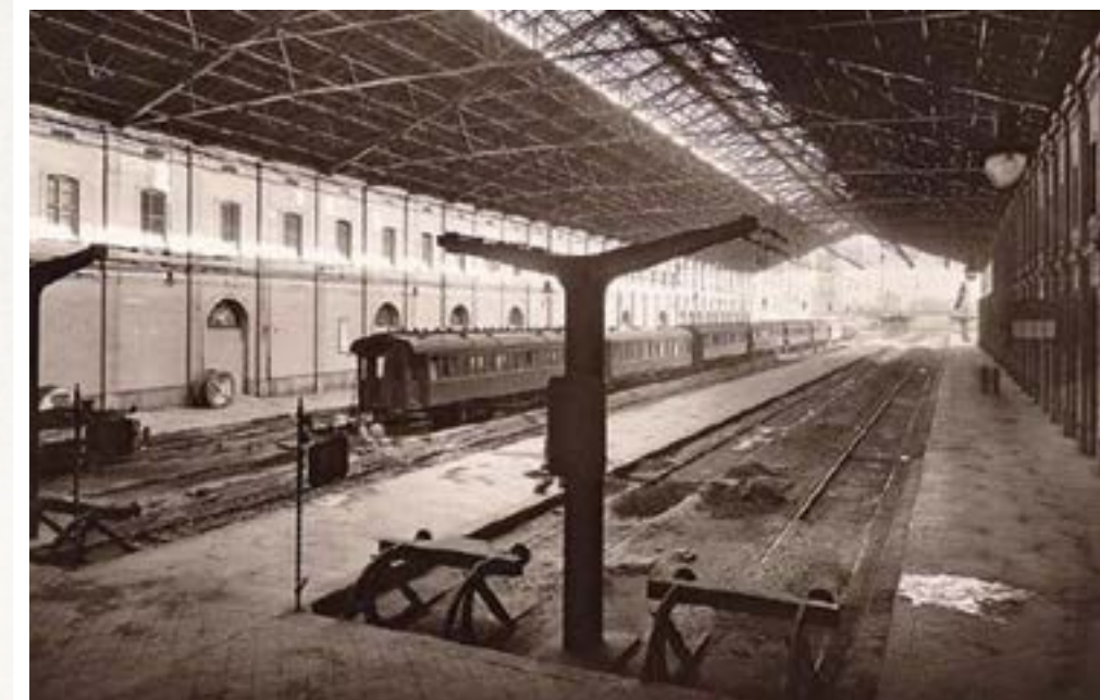
Estación de Barcelona Vilanova. Autor desconocido (años 30).
