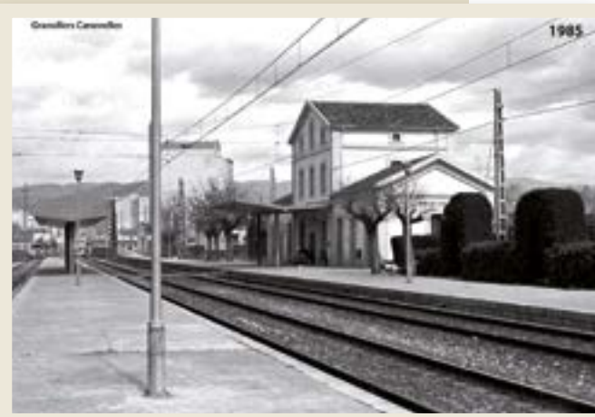
Estación de Granollers. Lluís Garcia Rifà (1985).
