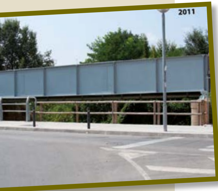
Puente sobre la Riera de Carbonell o de Corró. Único elemento que queda del trazado original de la línea en el tramo Granollers Centre en Les Franqueses. Lluís García Rifà (2011).
