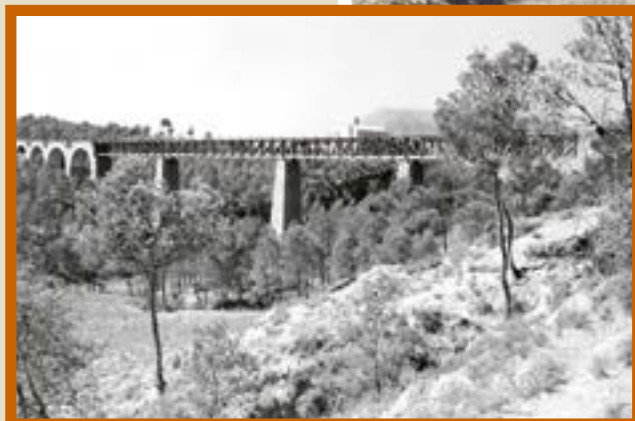
Visión del viaducto de Joncadella, antes de su reconstrucción con arcos de hormigón, con el santuario homónimo al fondo. Archivo FGC (1930).
