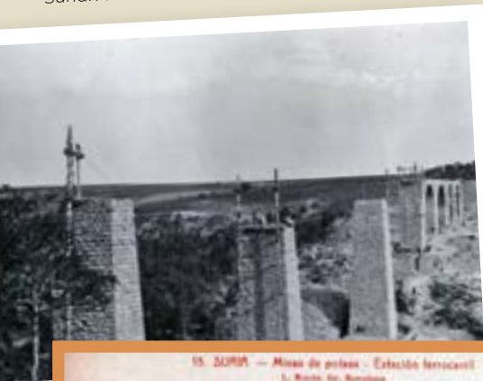
Construcción de uno de los numerosos puentes y viaductos metálicos de la línea de Manresa a Súria. Archivo ICL Iberia (1919).
