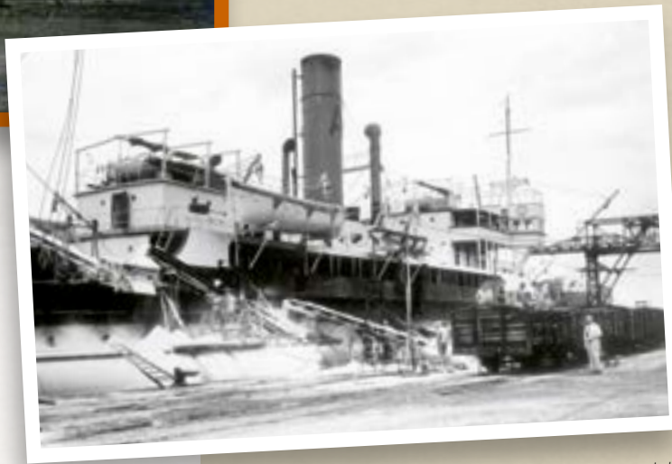
Tareas de transbordo de la carga minera del tren al barco en el Muelle del Contradique del puerto de Barcelona. Archivo FGC (c1950).
