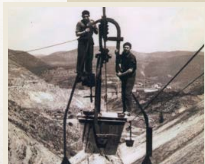
Las minas y la fábrica de Cardona se comunicaban con la estación ferroviaria de Súria mediante una línea de teleférico. Archivo ICL Iberia (c1940).
