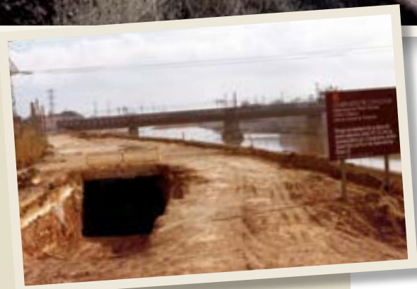
Construcción de la nueva línea de mercancías de Sant Boi de Llobregat al puerto de Barcelona. Archivo FGC (1984).
