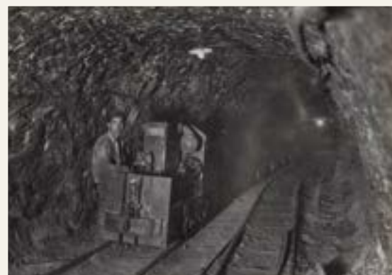
Las galerías mineras del Bages disponían de pequeñas instalaciones ferroviarias y maquinaria industrial para extraer la producción. Archivo ICL Iberia (1942).
