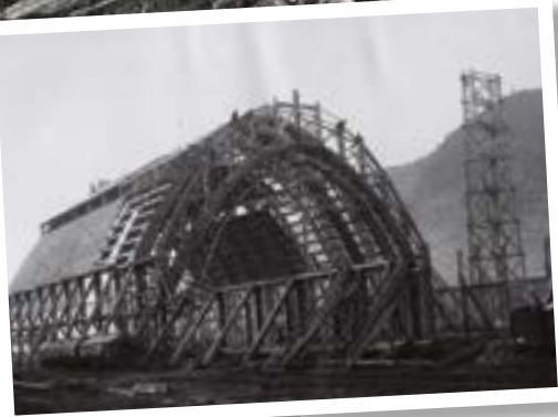
Construcción de los almacenes y las instalaciones mineras en Sallent. Archivo ICL Iberia (1934)
