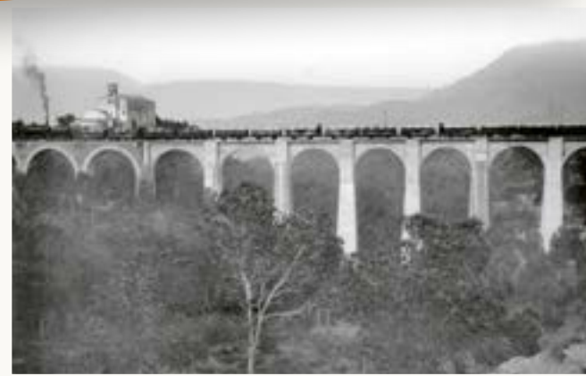
Una composición de tren con locomotora Garratt de los Ferrocarriles Catalanes en el viaducto de Joncadella. Archivo FGC (1951).
