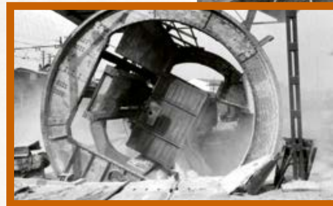
Tareas de transbordo de la carga minera de los vagones de vía estrecha a los de vía ancha en las instalaciones de Sant Vicenç de Castellet. Archivo Salmerón (1966).
