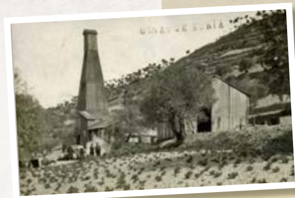
Primeros sondeos en la búsqueda de potasa en Súrria, en el lugar donde actualmente se encuentra ubicada la estación de FGC. Archivo ICL Iberia (c1913).
