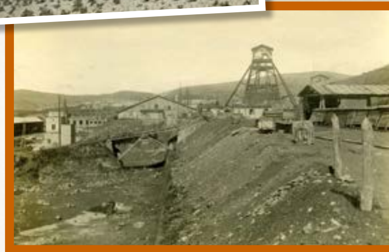
Obras de construcción de la fábrica y el pozo maestro en Súrria. Archivo ICL Iberia (c1919)
