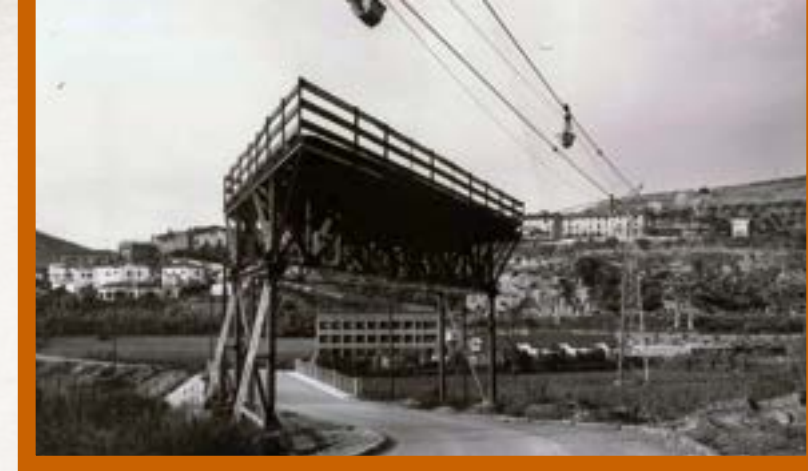
Las diferentes minas de Cardona y Súrria se comunicaban mediante diferentes líneas de teleférico. Archivo ICL Iberia (c1960).
