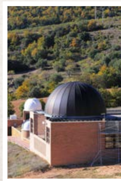
Imagen de las obras del COU en el Montsec de Ares (Jordi Bas)
